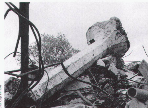
Robert Maillart, 3-geschossige Lagerhalle der Firma Gerhard & Hey, St. Petersburg, 1912. Nutzlast 1100 kg/m 2 unten: Trümmer der demolierten Lagerhalle der Firma Gerhard & Hey, St. Petersburg, 2001
