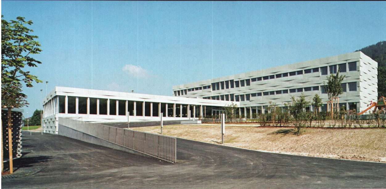
D. Jüngling + A. Hagmann, Schulhaus Oberfeld, Root 2005. – Bilder: Ralph Feiner
