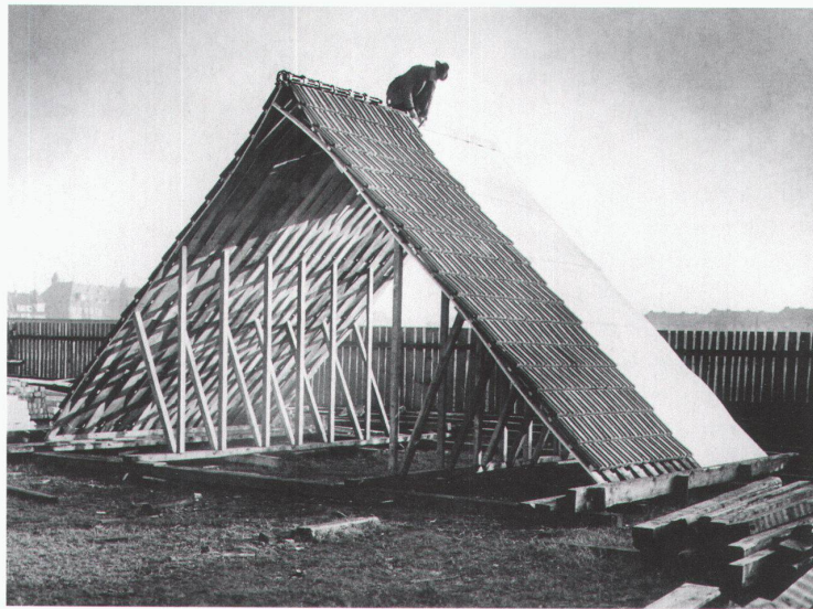
1:1 Modell eines Flechtwerkdachs der Firma Holzmann, 1931. – Bild: Architekturmuseum der TU München
