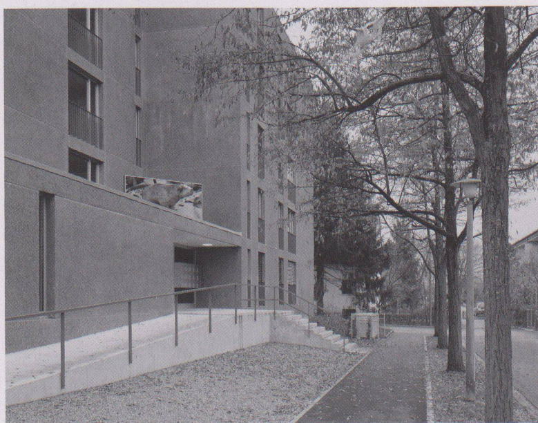
Bilder: Georg Aerni, von Ballmoos Krucker (Baustellenfotos)
