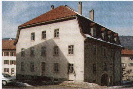
Dieses Haus in Bévillard (BE) stammt aus dem 18. Jh. und steht seit 15 Jahren leer. – Bild: SHS
