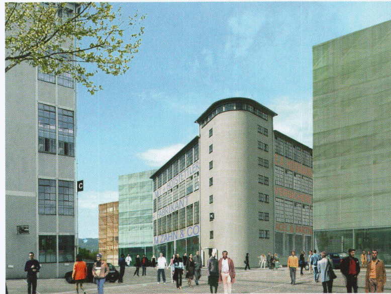
Verdichtung von Bausubstanz aus den 1930er-Jahren
