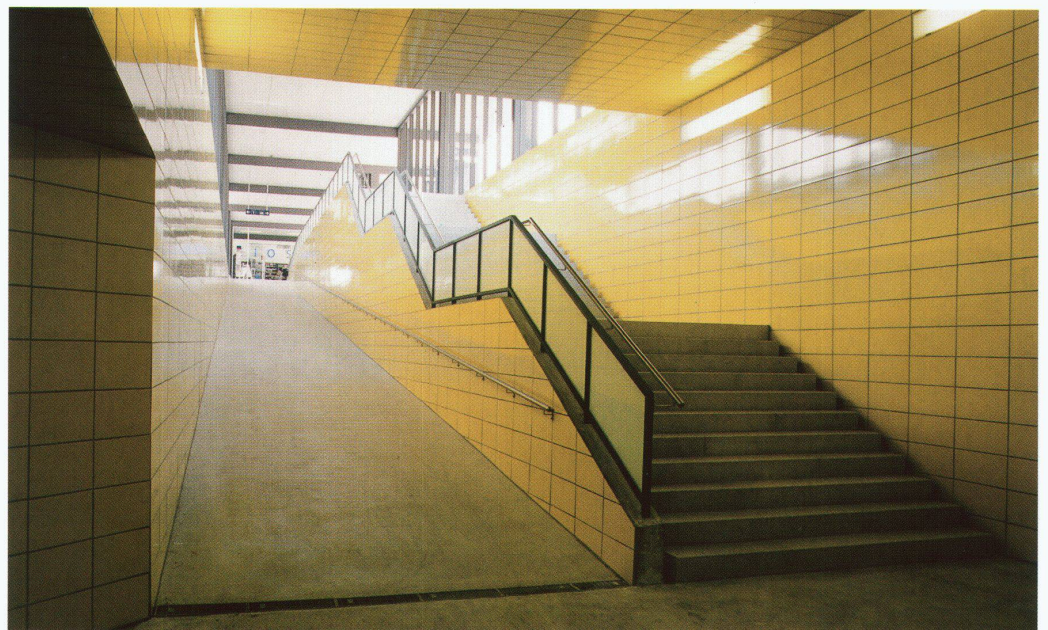
Hauptunterführung ▷ Sous-passage principal ▷ Main subway
