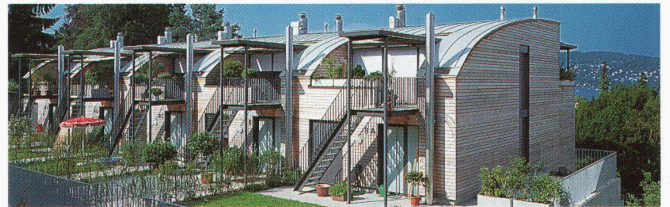
Objekt Wohnanlage „Seepark Wannan“ Architekten Atelier WW, Zürich
