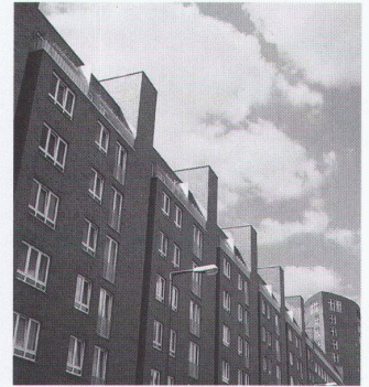
Josef Paul Kleihues: Wohnüberbauung Brunnenstrasse, Berlin Foto: Andreas Löhlein
