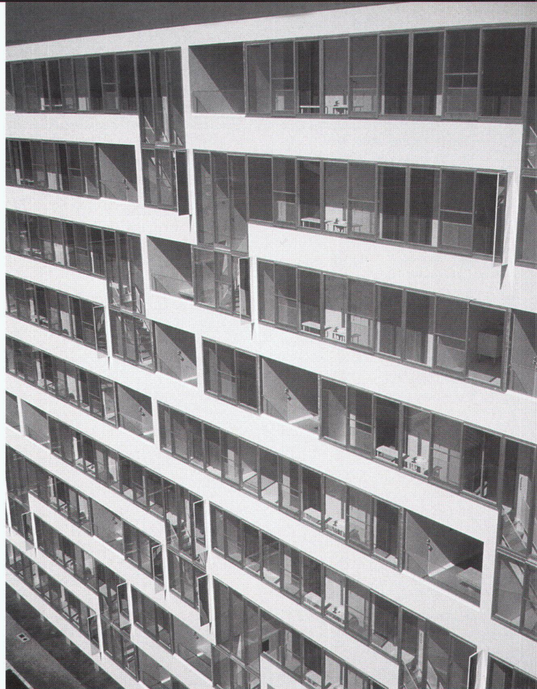
«Tiefe» Fassade in Motosu (Typ 3a) ▶ Façade «profonde» à Motosu (Type 3a) ▶ «Deep» facade in Motosu (Type 3a)
