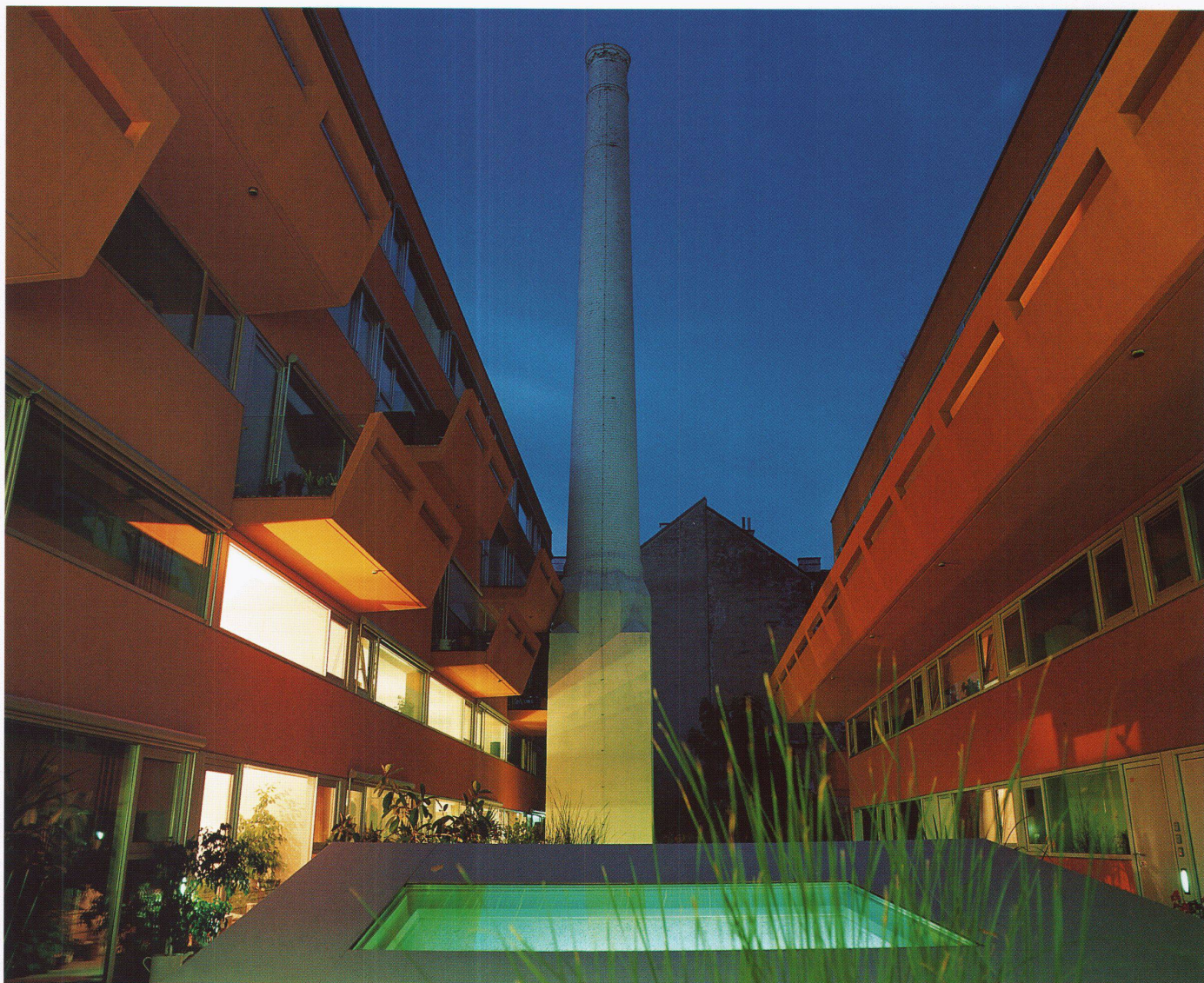
Balkone mit seitlicher Verglasung und Brüstungsschlitzten auf Kinderaugenhöhe ▶ Balcons avec vitrage latéral et fentes en allège à hauteur d'œil des enfants ▶ Bal- conies with lateral glazing and para- pet viewing slits at the eye-level of children
