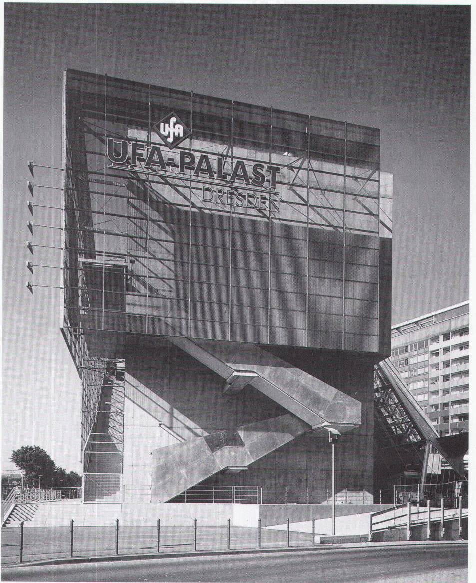
Ansicht von Norden 2. Obergeschoss
