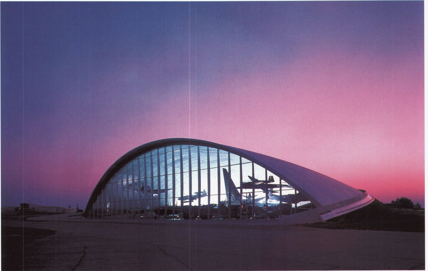
Ansicht von Nordosten ■ Vue du nord-est ■ View from north-east
