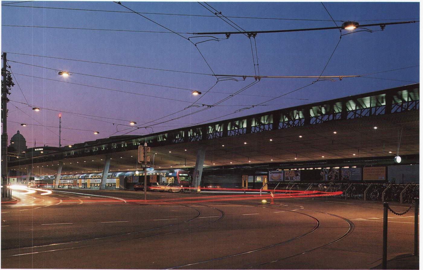
Nördliches Dach ■ Toit nord ■ North roof
