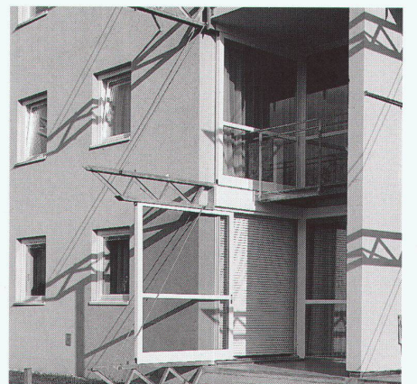
Loggia mit den auskragenden Schiebefenstern ■ Loggia avec fenêtres coulissantes projetées ■ Loggia with projecting sliding windows
