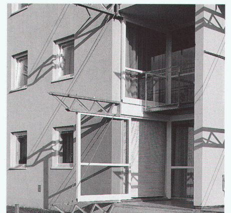
Loggia mit den auskragenden Schiebefenstern ■ Loggia avec fenêtres coulissantes projetées ■ Loggia with projecting sliding windows
