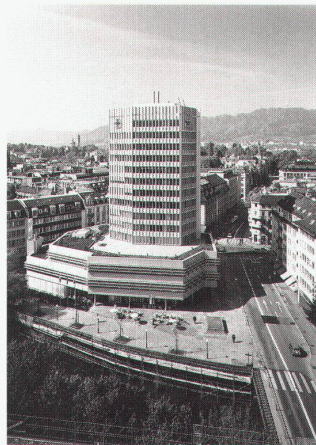
Hochhaus zur Schanzenbrücke, Zürich: 6000 m 2 Flachdächer-, Terrassen-, Unterterrain- und Grundwasserabdichtungen.
