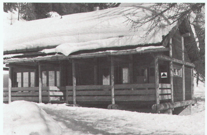
Haus «Pfah», Bellwald
