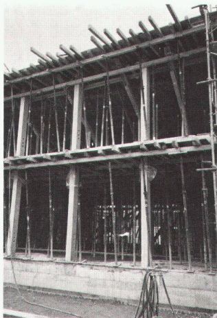
Bei einem Fabrikationsgebäude werden die Geschossdecken und das Dach durch stabilste Säulen abgestützt.
