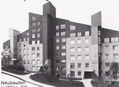
Neubauten in Wilen, SG. Überbauung mit Holz/IV-Fenstern.
