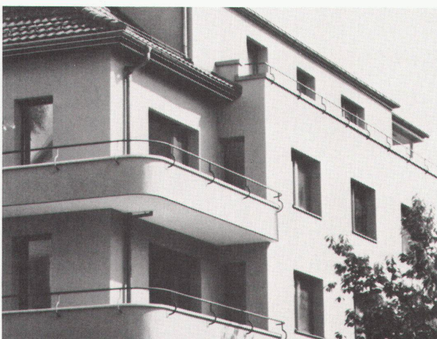
- Mehrfamilienhaus-Sanierung, Dübendorf. 1980. Aussenisolation.
