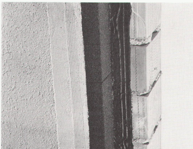
- Maueraufbau mit Permisol
