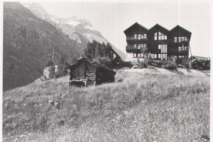
3 Haus Palma in Zermatt während des Baus. Vom Massivsockel bis zu den Pfetten durchlaufende Zangenstützen und Riegel in 2,75-Träger-Abstand, darauf Balken- respektive Sparrenlage als Primärkonstruktion Maison Palma à Zermatt pendant la construction. Supports de poutres traversières qui sont continus depuis le socle jusqu'aux pannes, et traverses dans un écartement de 2,75, par-dessus, respectivement poutrage et chevronnage en
