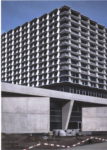
Das Bürgerspital Solothurn von Silvia und Reto Gmür setzt mit seinen Brise-Soleil aus Beton ein Zeichen in der Landschaft. Das Verschattungssystem ermöglicht jederzeit einen freien Blick aus den Patientenzimmern ins Freie. → S. 33 Bild: Ralph Feiner
