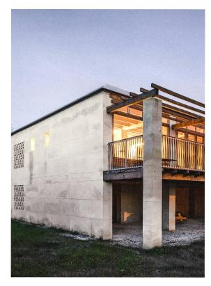
Aussenwände und Säulen sind aus schweren Kalkblöcken gefügt. Bild: 11h45
