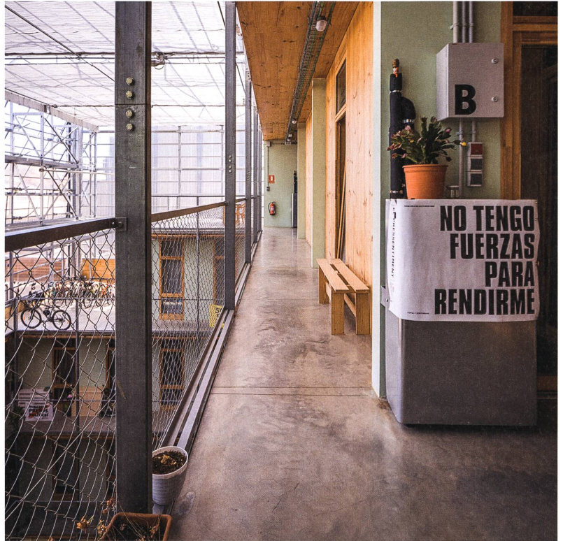
Der glasbedeckte Lichthof als soziales Zentrum des Hauses erweitert sich zu einem hohen Gemeinschaftsraum. Das Glasdach spendet im Winter Wärme, im Sommer lässt es den Wind durchs Haus zirkulieren. Bild: Lluc Miralles
