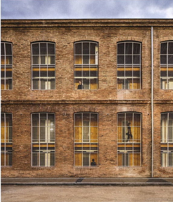
Ansicht vom Hof: Die Holzeinbauten der Künstlerwohnungen berühren die historische Fassade nicht.
