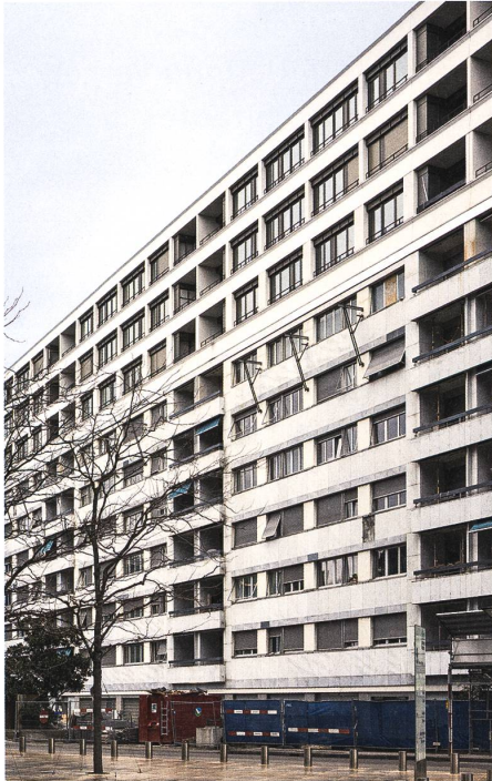
Die Massivität des Betonbaus setzt sich in den drei aufgesetzten Geschossen fort, auf der Hofseite ebenso das Gitter von Fensterposten und Brüstungen.
