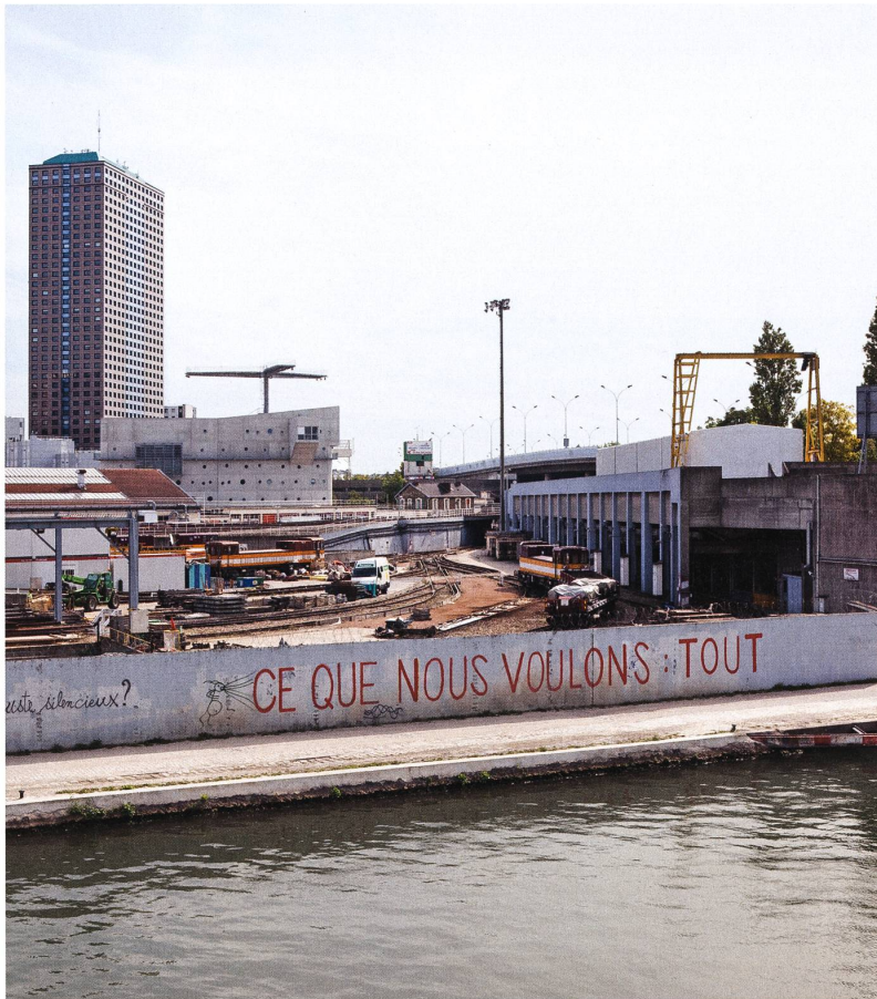
Die Pariser Banlieue in Erwartung des Wandels: Baustellen am künftigen Metro-Knotenpunkt St-Denis Pleyel. Bild: Clément Guillaume
