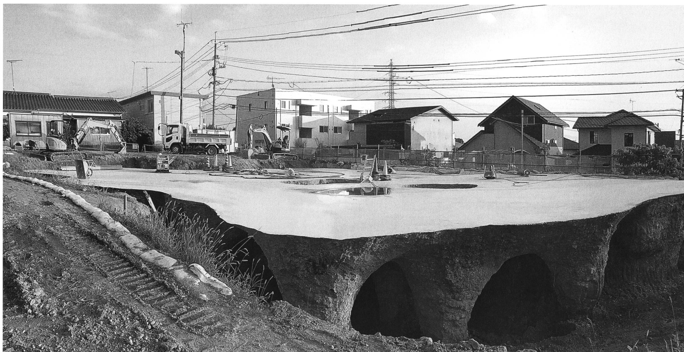
Die Negativform des Aushubs wurde nach dem Ausbetonieren und der Entfernung der umliegenden Erde zum architektonischen Objekt. Bild: Architekten
