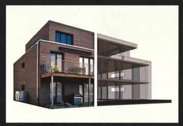
Mit TS3 wird klimaschonend gebaut. Denn TS3 ermöglicht Grossflächen aus Holz. So ersetzt Holz den traditionellen Stahlbeton in vielen Bereichen — Rohbauten aus Holz sind heute möglich. Das ist sinnvoll, denn das traditionelle Baumaterial Beton hat einen gewichtigen Nachteil: Die Produktion von Stahl und Beton ist sehr energieintensiv. Die Herstellung
