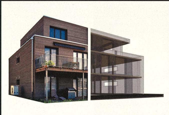
Mit TS3 wird klimaschonend gebaut. Denn TS3 ermöglicht Grossflächen aus Holz. So ersetzt Holz den traditionellen Stahlbeton in vielen Bereichen – Rohbauten aus Holz sind heute möglich. Das ist sinnvoll, denn das traditionelle Baumaterial Beton hat einen gewichtigen Nachteil: Die Produktion von Stahl und Beton ist sehr energieintensiv. Die Herstellung
