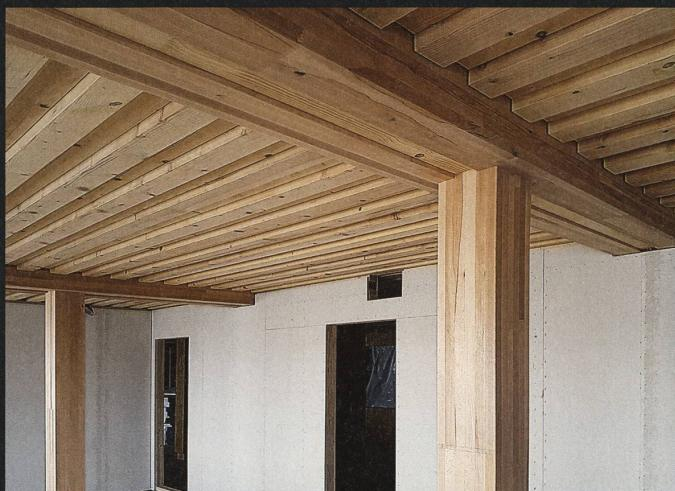
Endlich stehen homogene Bauteile aus Schweizer Buchenholz für grosse Spannweiten und hohe Anforderungen zu Verfügung. Seit Anfang 2020 läuft im Werk von Fagus Suisse in Les Breuleux die Produktion von Hochleistungsbauteilen aus Buchenholz aus einheimischen Wäldern. Die klimafreundliche Alternative zu
