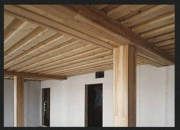
Endlich stehen homogene Bauteile aus Schweizer Buchenholz für grosse Spannweiten und hohe Anforderungen zu Verfügung. Seit Anfang 2020 läuft im Werk von Fagus Suisse in Les Breuleux die Produktion von Hochleistungsbauteilen aus Buchenholz aus einheimischen Wäldern. Die klimafreundliche Alternative zu Stahl und Beton kommt bereits bei diversen grossen Bauprojekten zum Einsatz.
