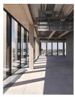
Metall-Curtainwall und hybrider Holz-Betonverbund. Bild: Kuster Frey
