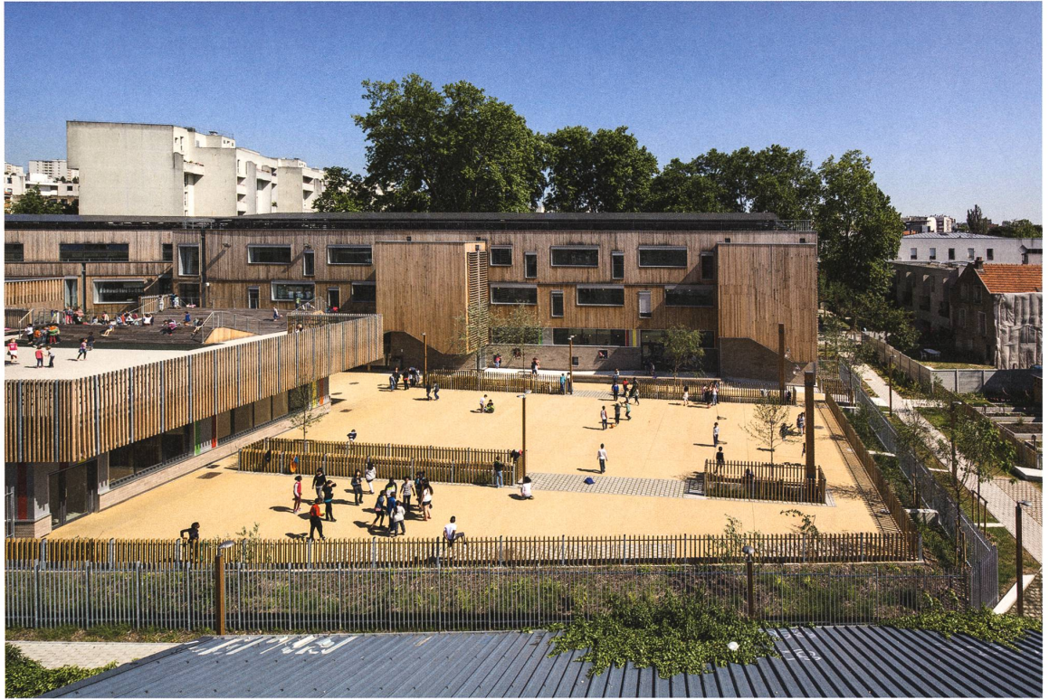
Schulanlage in Montreuil bei Paris, Meandre Architecture (2014). Fassade aus Holzboxen mit Strohdämmung. Bild: Luc Boegly
