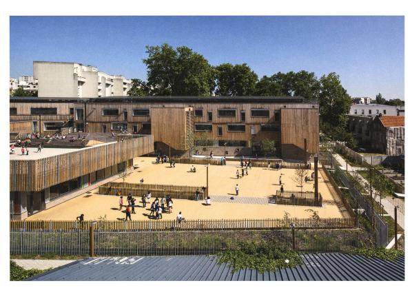
Schulanlage in Montreuil bei Paris, Meandre Architecture (2014). Fassade aus Holzboxen mit Strohdämmung. Bild: Luc Boegly
