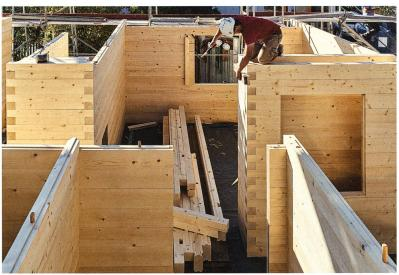
Fliessender Raum und gestrickte Kammern: Im Erdgeschoss mit zweischaliger Strickwand sind offene und geschlossene Räume kombiniert «wie ein Weiler aus Alphütten» – dazu passt der Boden aus Stampflehm.
