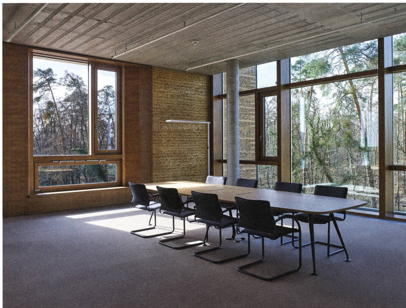
Die rund 90 Meter langen Nord- und Süd-fassaden bestehen aus Stampflehm. Die verglasten Schmalseiten eröffnen Blicke über das alte Kasernengelände nach Osten und den Kiefernwald im Westen.
