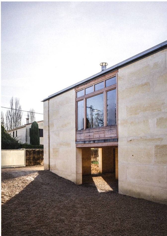
Aus Kalkstein gefügt: Wände und Stützen des Hauses in Montélimar von Gilles Perraudin (vgl. S.13). Bilder: 11h45
