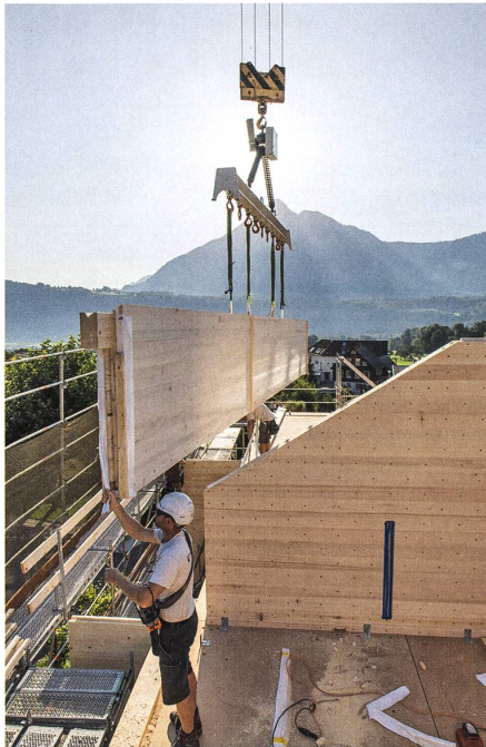
Der Vollholzbau in Alpnach von Seiler Linhart kennt weder Leim noch Metall oder chemische Bindemittel. Einzig ein Windpapier klemmt zwischen zwei jeweils 20 Zentimeter starken Schichten mit kreuzweise verdübeltem Vollholz. → S. 29 Bild: Samuel Büttler
