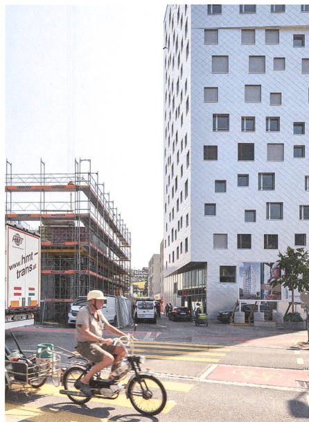
Das Hochhaus von Tilla Theus ist Vorbote einer rasanten Entwicklung rund um den Bahnhof Horw. Die Bildstrecke von Roman Keller zeigt die Verwandlung an den Rändern Luzerns → S. 6 Bild: Roman Keller
