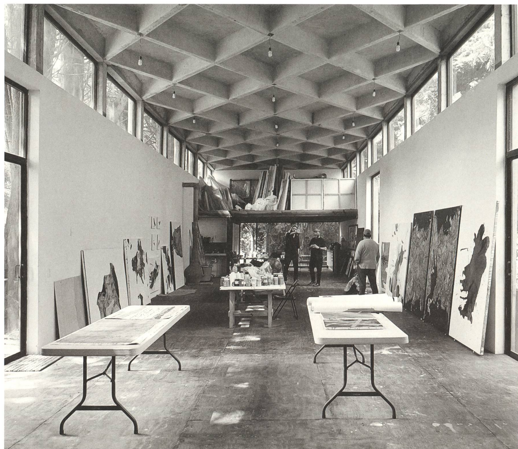
Eine leichte und direkte Betonkonstruktion: Derek Dellekamp und Jachen Schleich, Atelier Roel in Mexiko-Stadt, 2017. Bild: Laure Nashed
