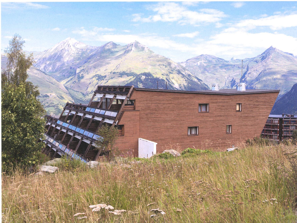
Arc 1800, Quartier Charvet, 1973–76, Charlotte Perriand (Bild oben)
