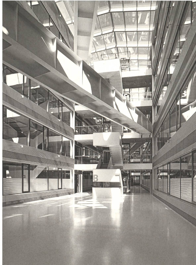
Swisscom-Businesspark in Ittingen, 2012–14 von Atelier 5 und EBP als zurückhaltend technisiertes Gebäude geplant und realisiert. Bild: Dominique Uldry
