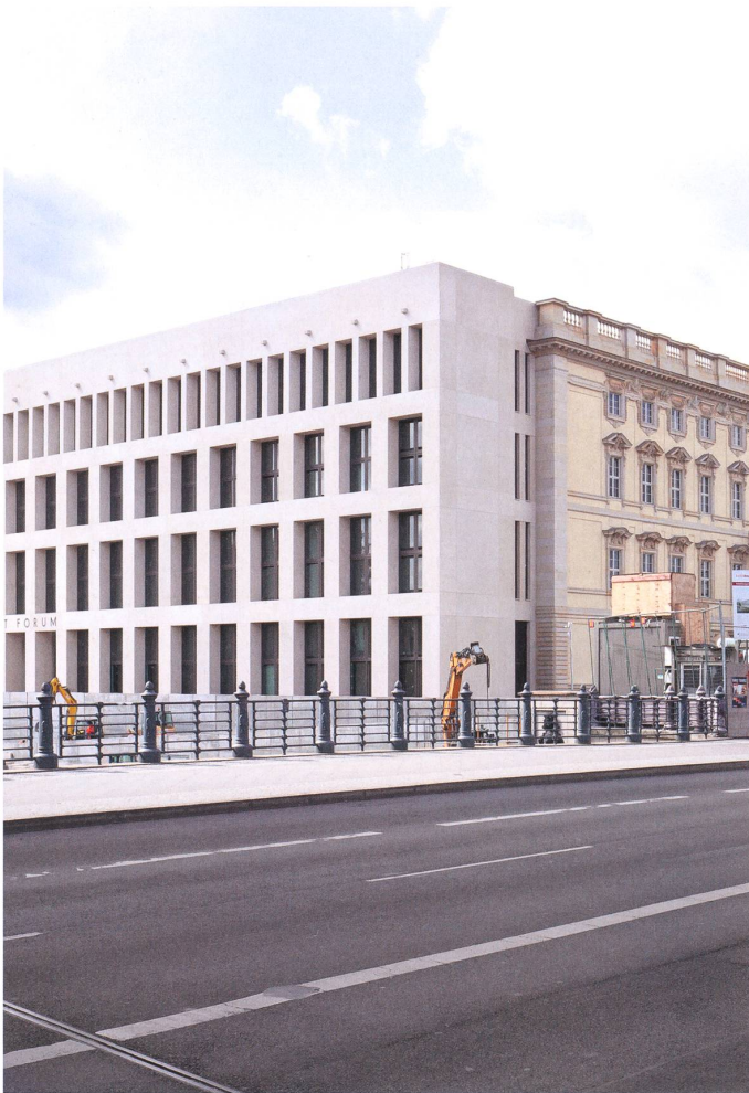
Die neue Ostfassade ist als eigenes Bauwerk konzipiert, sie steht an der Stelle der ältesten Teile des Schlosses.
