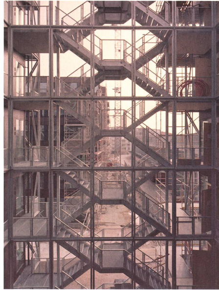
Fluchttreppenhaus und Ausblick Richtung Blumengrossmarkt. Bild: Rory Gardiner.
