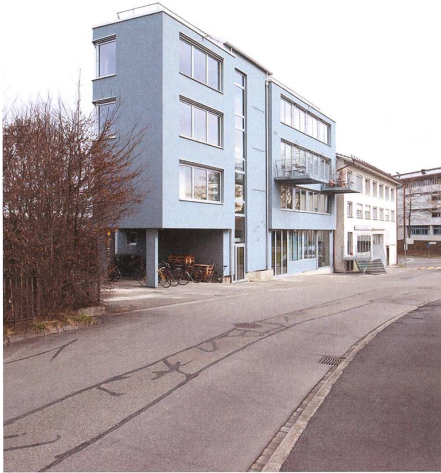
Zu Wohnungen und Ateliers umgebaut, gibt dieser Gewerbebau in Bern Anlass, über den Wert gewöhnlicher Architektur nachzudenken. → S. 56 Bild: Marco Frauchiger
