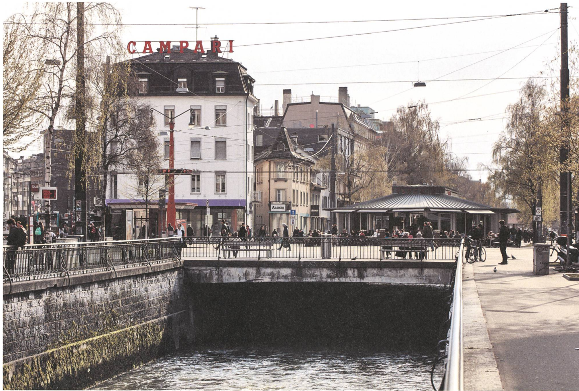
Der Zentralplatz überbrückt die Schüss
