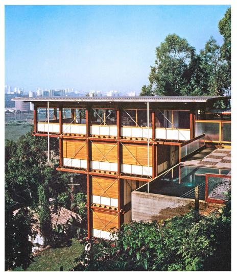
Am kaum bebaubaren Steilhang bauten der Ingenieur Hélio Olga und der Architekt Carlos Acayaba ein Haus als Brücke in einer modularen Bauweise.
