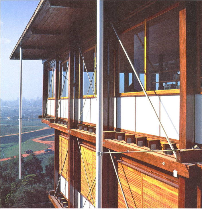
Sichtbar gefügt: Die Konstruktion ist als feingliedriges Relief an der Fassade ablesbar – geschützt durch Vordach und Auskragungen.
