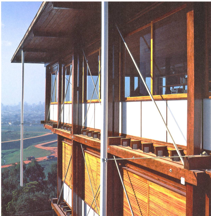
Sichtbar gefügt: Die Konstruktion ist als feingliedriges Relief an der Fassade ablesbar – geschützt durch Vordach und Auskragungen.
