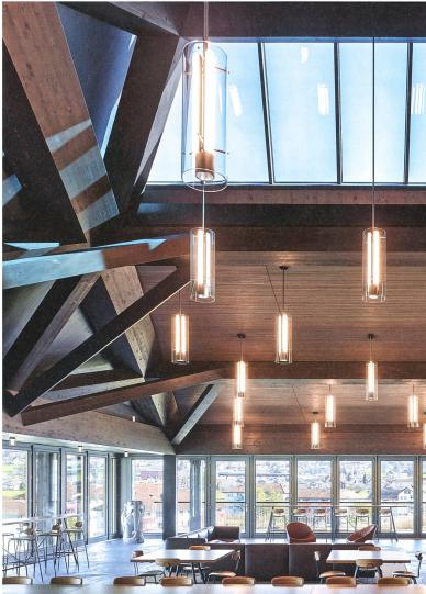
Die Dachkonstruktionen im hoch gelegenen Kundenbereich folgen bildhaft japanischer Architektur (Bild links oben) – aber auch einer ganz eigenen Logik des Überspannens: Als eine Kombination von Sprengwerk und Fachwerk-Ausleger für möglichst uneingeschränkte Aussicht im Verpflegungsraum (rechts) und in den Kursräumen (unten).
