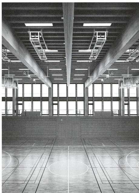
En périphérie de chaque bâtiment, des portiques en béton armé coulé in situ forment une façade durable aux différentes fonctions. La salle de gym et partiellement enterrée. Photos: Rasmus Norlander
