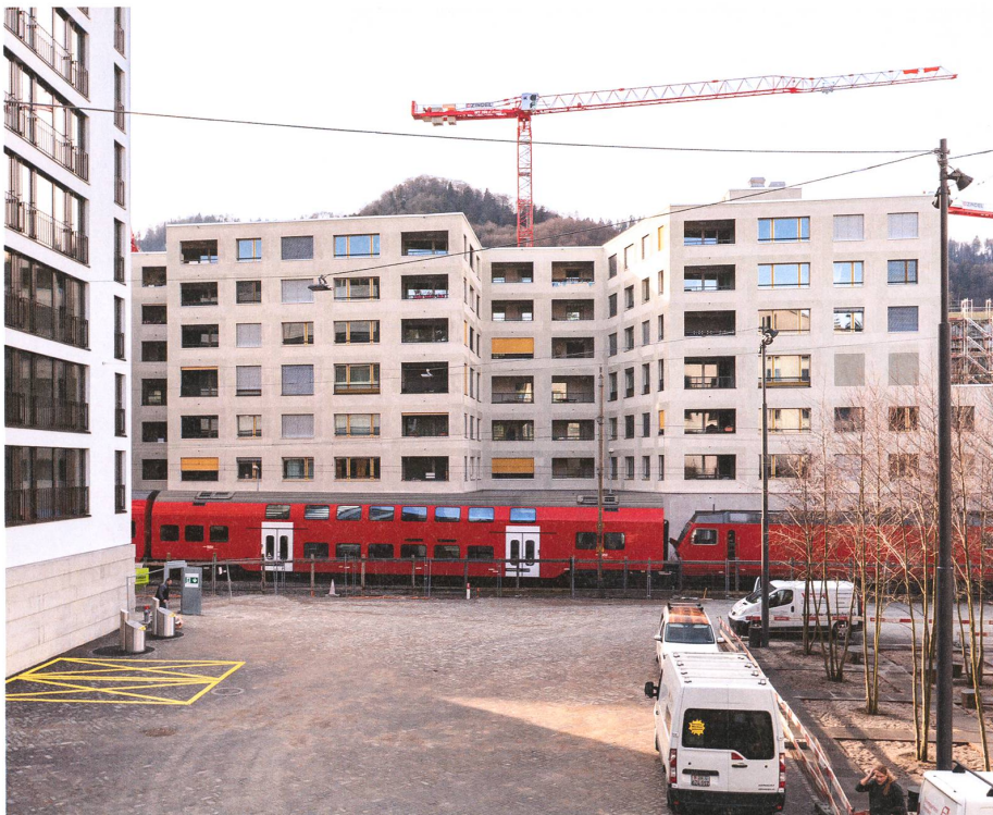
Asphalt von Tür zu Tür: Die Allmendstrasse wurde nicht als Quartierboulevard ausgebaut, sondern als Schnellstrasse. Abbiegespuren beschneiden das Trottoir vor dem Genossenschaftshaus von EM2N.
