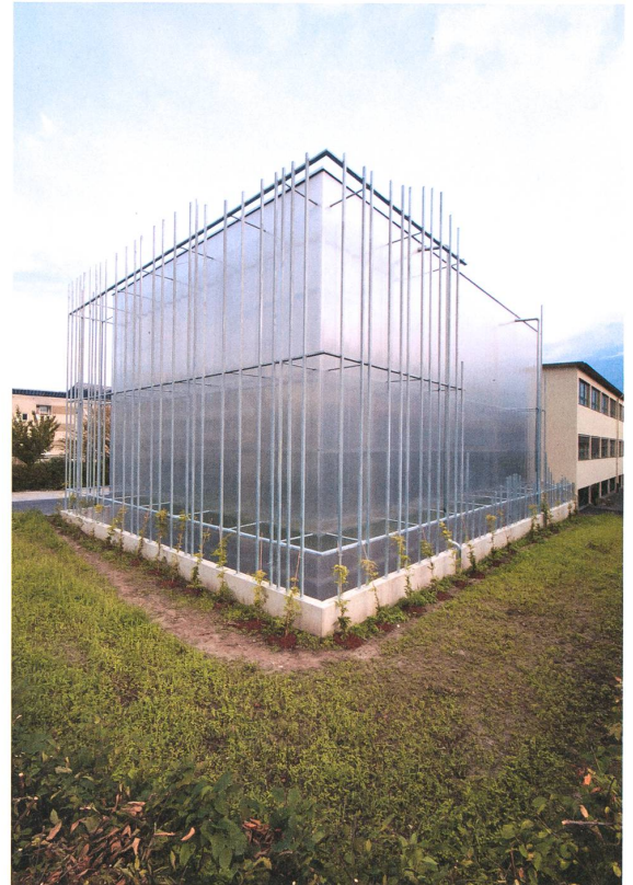
Der Baukörper steht in einer Betonwanne. Vor einem umlaufenden Zwischenraum wachsen Glyzinien hoch. Bild: Katharina Gürtler
