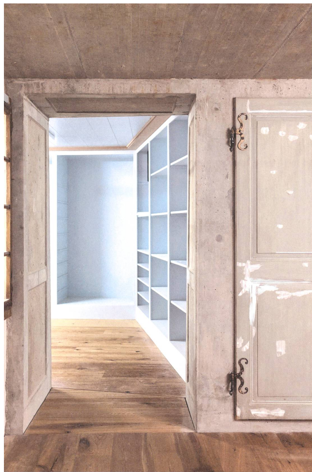
Blick ins Ateliergeschoss – auf der neuen Betonwand ist eine alte Tür rahmenlos aufgesetzt.
