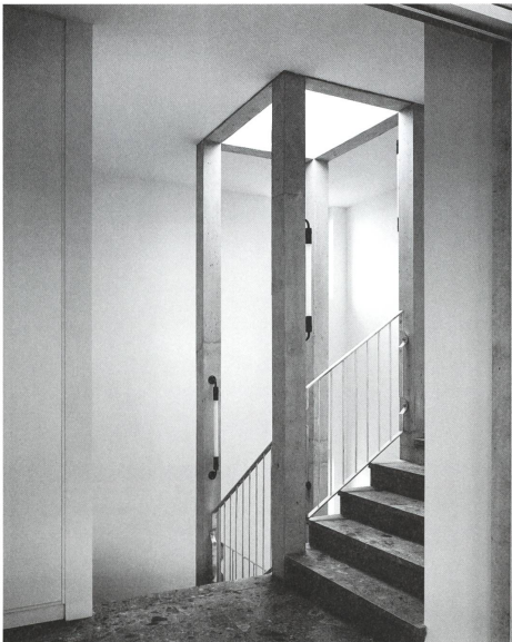
Die Einfassungen der Fenster sind aus Dämmbeton, die Wandstücke dazwischen aus Einsteinsmauerwerk.
