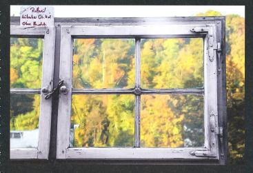
Rethermo:: Das vorhandene Glas wird bei der Herstellung des Isolierglases als komplettes Element in das neue Isolierglas integriert.
