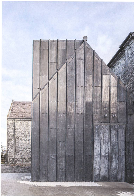
Die Kirche wird zum Museum ihrer eigenen Geschichte, das wieder aufgebaute nördliche Seitenschiff ist in Blei gekleidet: St. Mary's in Kilkenny. → S. 25 Bild: Christian Richters
